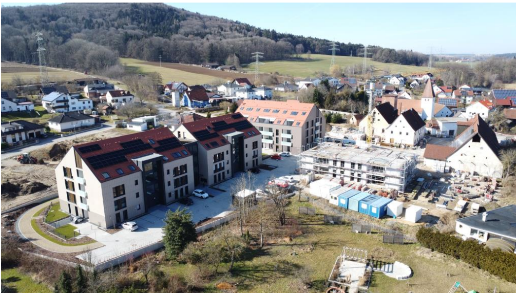
Aktueller Baustand März 2025
