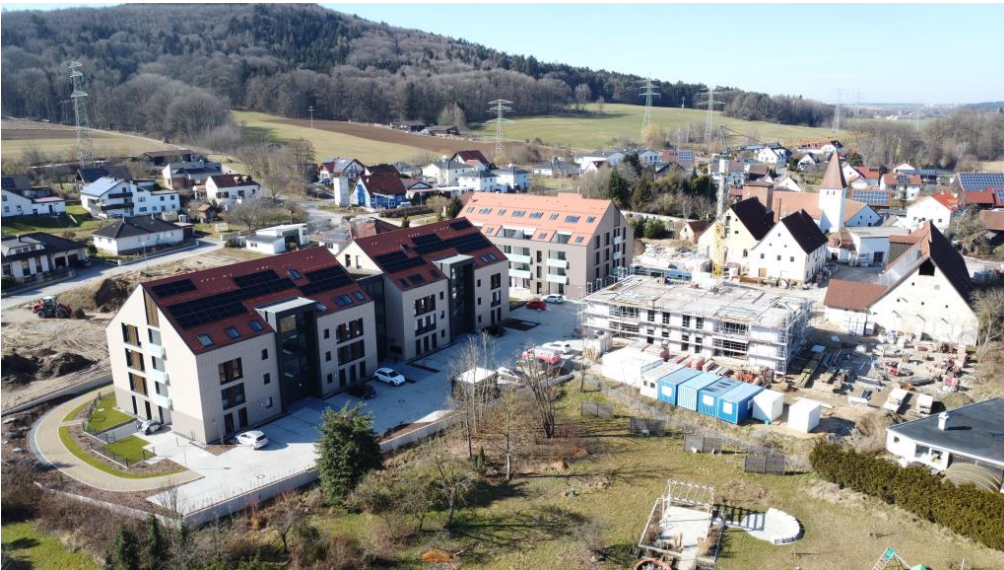
Aktueller Baustand März 2025
