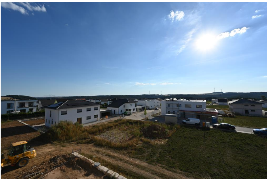
Blick über die Dächer
