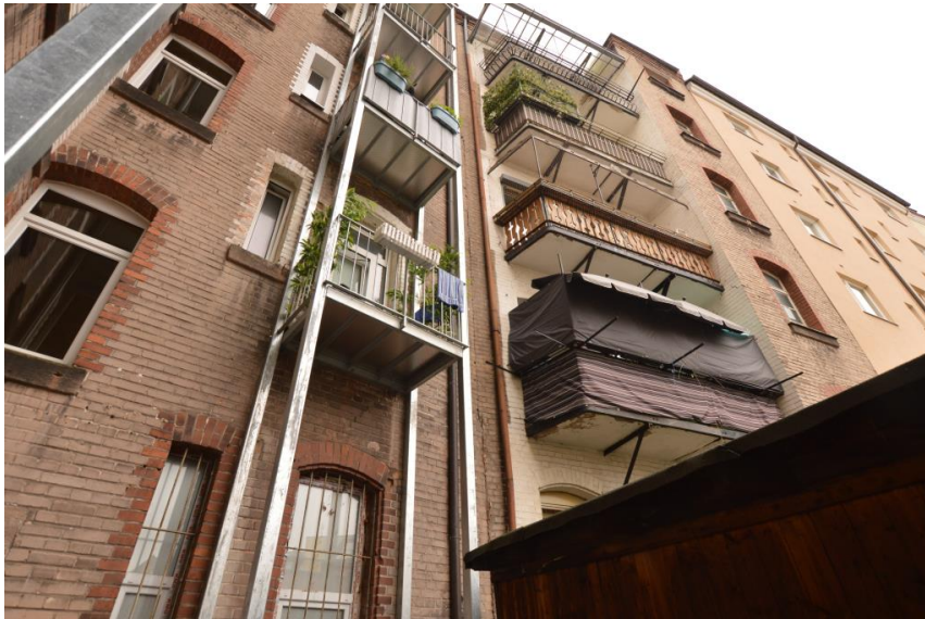
Balkone wurden nachgerüstet
