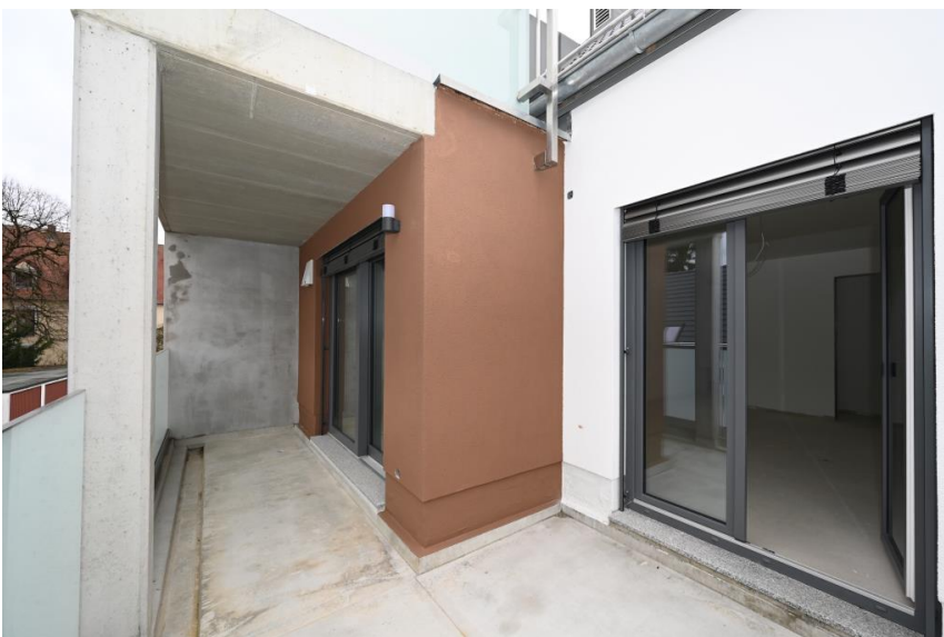
Überdachter u. offener Balkon
