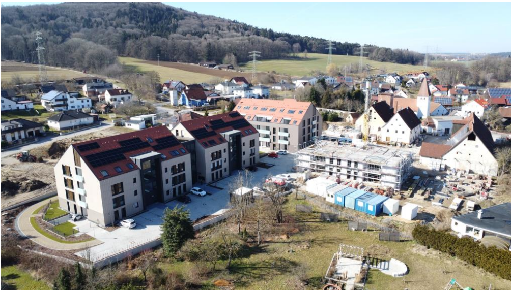
Aktueller Baustand März 2025
