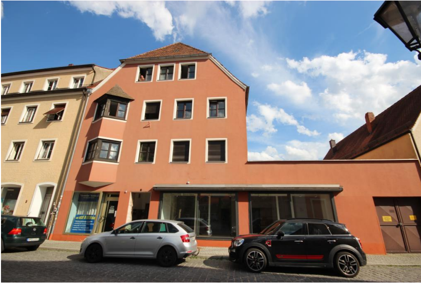
Neue + großzügige Schaufenster
