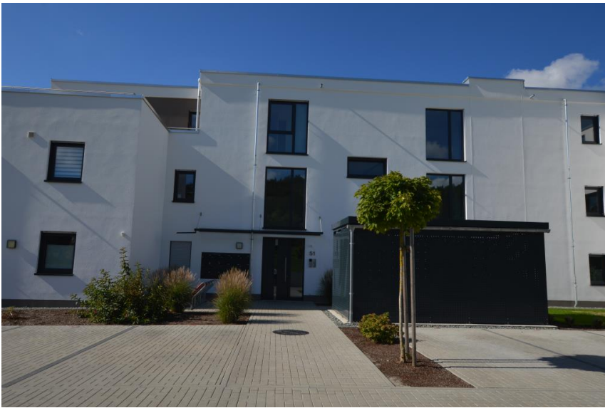
Barrierefrei mit Aufzug
