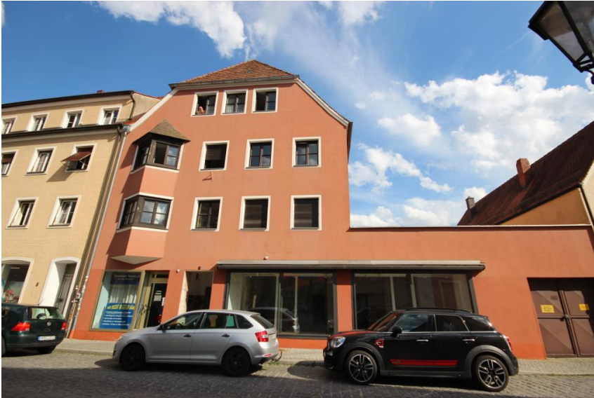
Neue Schaufenster mit Thermoglas
